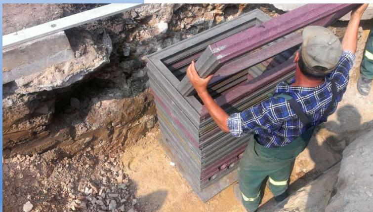
**Materiał :** mieszanina odpadowego polietylenu i polipropylenu
